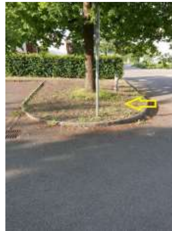
Abb.geff001.07 - Baumumfeld stark eingeschränkt
