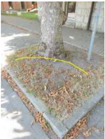
Abb.gefs003.37 - Ungenügend grosse Baumscheiben, entstehende Wurzelstockanhebung, Kandelaber Fundament in der Baumscheibe
