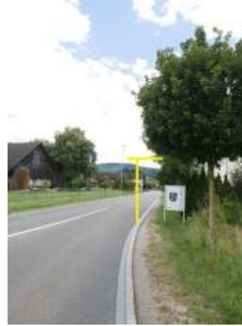
Abb.gef1001-003.19 - Lichtraumprofil strassenseitig zu tief
