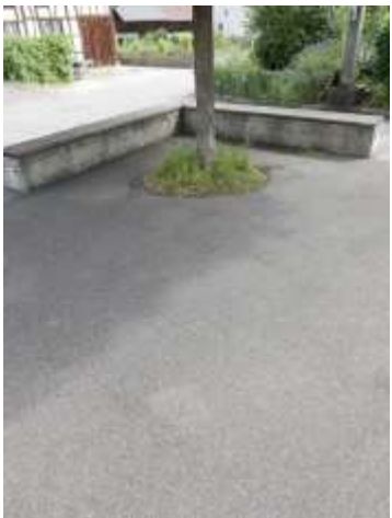
Abb.gfvk001.61 - Enge Platzverhältnisse, zu kleine Baumscheibe
