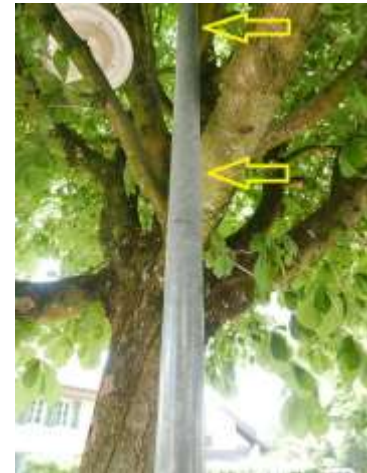
Abb.gefs001.32 - Bevorstehende Reibstelle an Kandelaber
