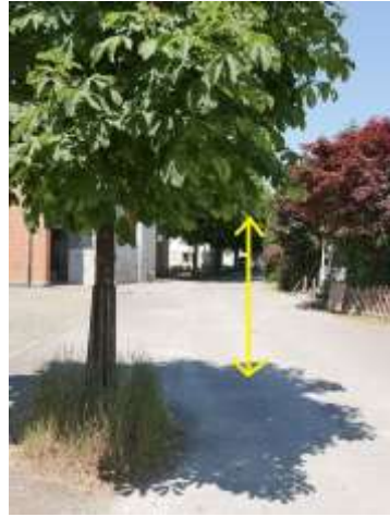
Abb.gefs007-015.42 - Ungenügende Baumscheibengrösse, Lichtraumprofil zu tief
