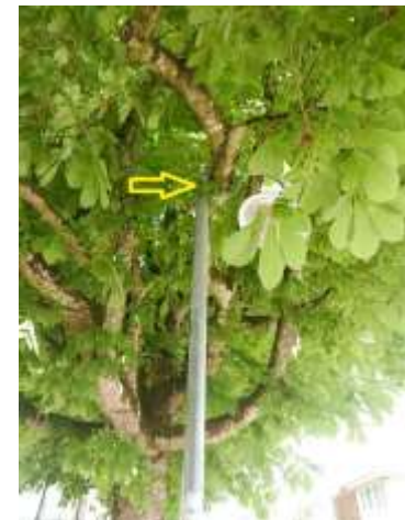
Abb.gefs006.40 - Kandelaber in der Baumkrone, entstehende Reibstelle
