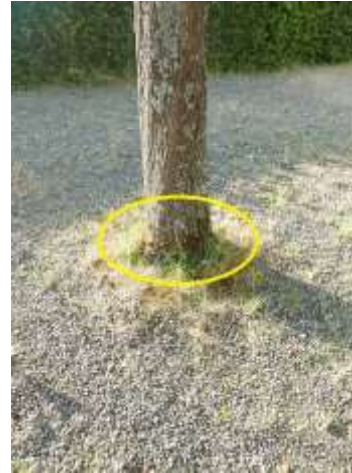
Abb.geff004.11 - Wurzelanläufe nicht sichtbar, zu tief gepflanzt. Baumumfeld Chaussierung.
