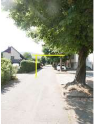
Abb.gefs001.33 - Lichtraumprofil zu tief
