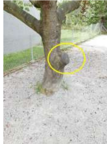
Abb.gfsc006.59 - Starkastentnahme, Wurzelraum chaussiert
