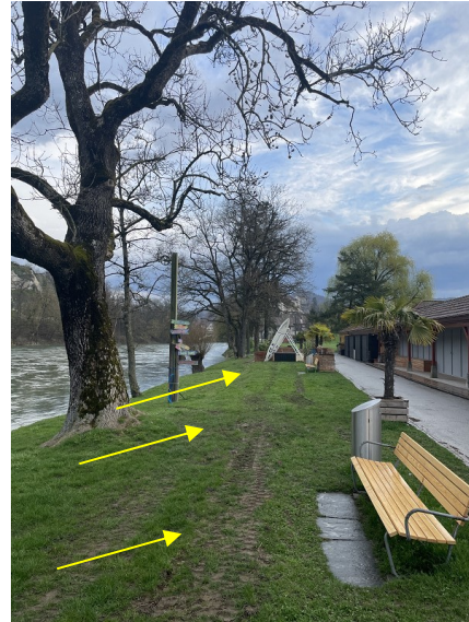
Spuren von Bagger
